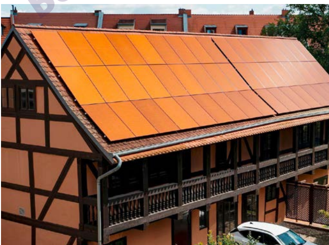
2 An die Dachziegel optisch angepasste PV-Module an einem Fachwerkhäus in Brandenburg
