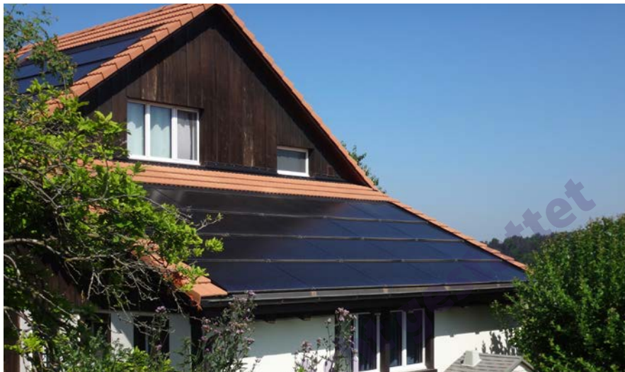
1 In der Schweiz nicht ungewöhnlich: Indachanlage mit rahmenlosen PV-Modulen
