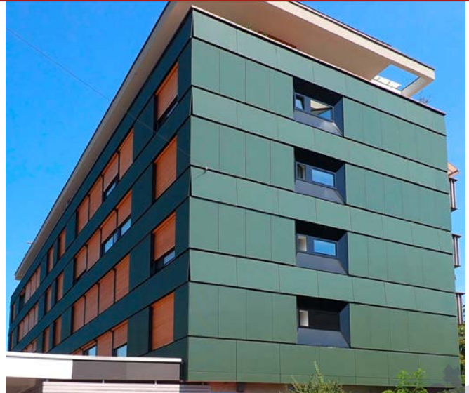
8 Fassadenanlage aus rahmenlosen PV-Modulen mit grün geriffelter Oberfläche an einem Mehrfamilienhaus in Basel
