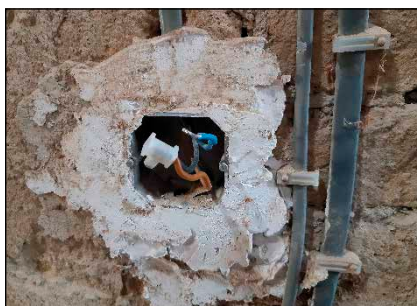
Bild 4: Bilder der alten Elektroinstallation vor Ort: Aluminiumleitungen und Bakelitsteckdosen in Hohen Neuendorf; Aluminiumleitungen und TGL-Verteilerdose aus der DDR bei Pasewalk, Kupferleitungen und Sicherungskasten in einer Wohnung in München
