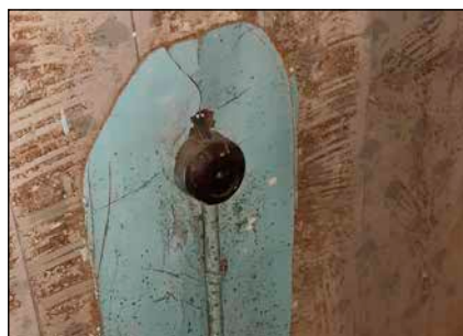
Bild 4: Bilder der alten Elektroinstallation vor Ort: Aluminiumleitungen und Bakelitsteckdosen in Hohen Neuendorf; Aluminiumleitungen und TGL-Verteilerdose aus der DDR bei Pasewalk, Kupferleitungen und Sicherungskasten in einer Wohnung in München
