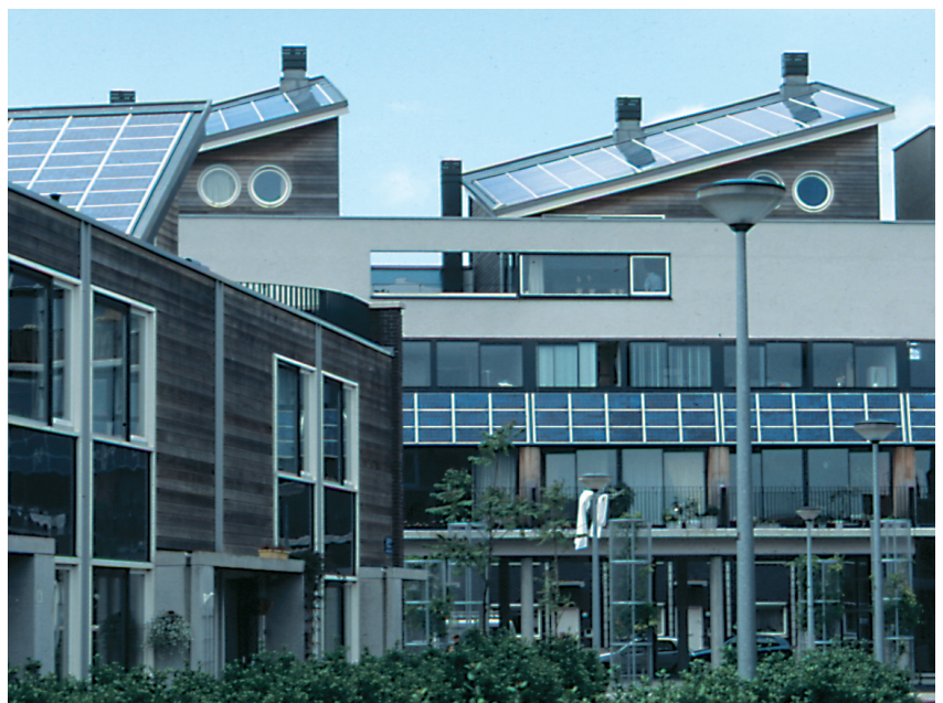
Bild 8-2: In der Siedlung New Sloten in Amsterdam wurde Photovoltaik auf unterschiedliche Weise an den Gebäuden integriert
